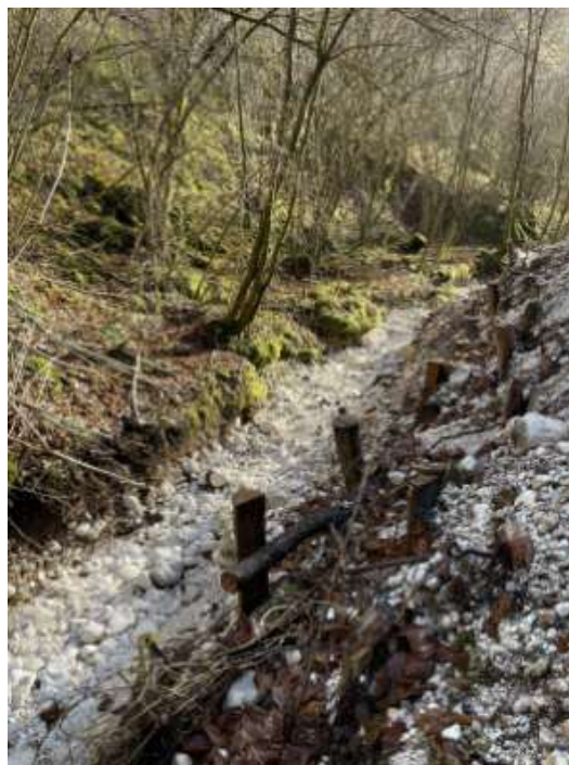
Slika: utrjevanje brežine s koli
