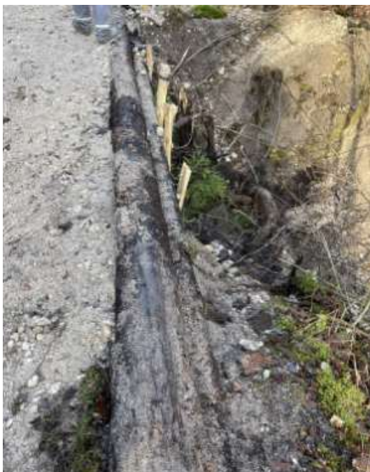
Slika: na novo utrjena pot, novi nosilci in preusmeritev hudournika pri Kal Koritnici
